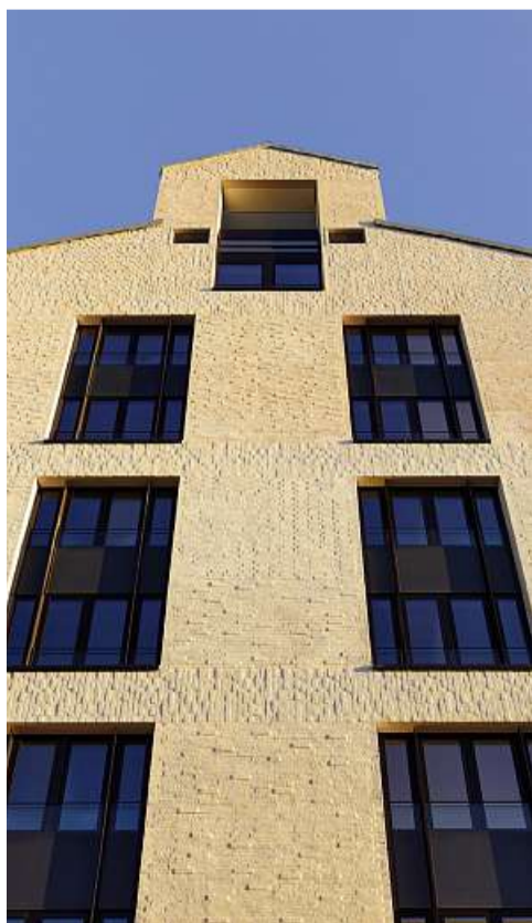
Tektonisches Aufschichten von Doppelgeschossen mit geschlängelten Backstein der Vormauerschale. FOTO: TIM HUPE ARCHITEKTEN GmbH, Hamburg
